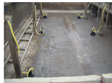
"Tauchbelüfter von Tsurumi: Fällt gelöstes Eisen im Wasser aus, bevor es die Filter erreicht (Foto: Tsurumi)"
