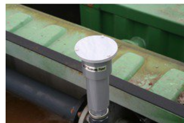
"Lösung mit Köpfchen: Der Luftansaugstutzen des Tauchbelüfters ragt aus dem Wasser (Foto: Tsurumi)"
