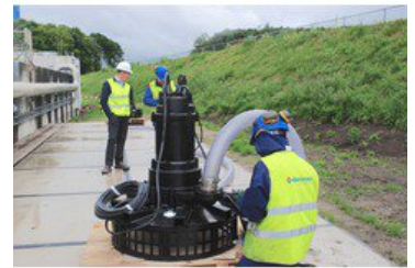
Anlieferung der Tauchbelüfter in Wijster. Verblüffend: In wenigen Minuten schon läuft der Klärbetrieb, weil diese Geräte keine eigene Infrastruktur benötigen. (Foto: Tsurumi) Download Foto
